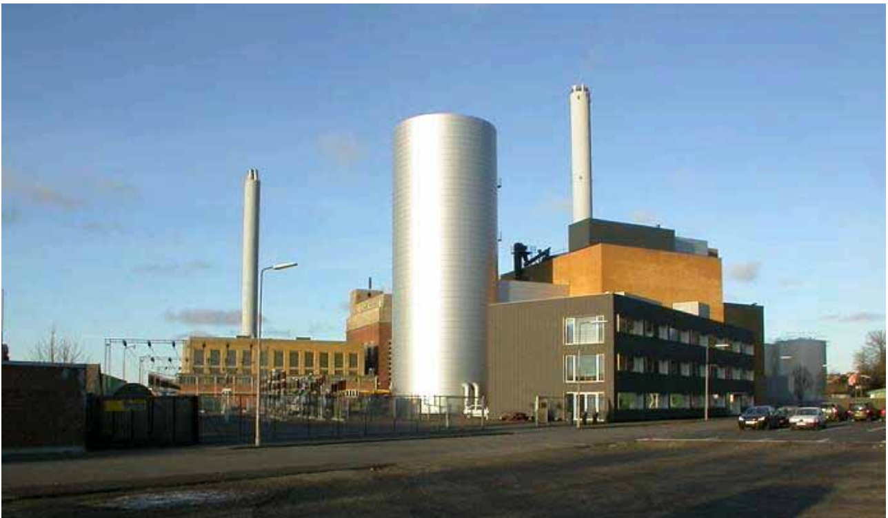
Østkraft, 2004. Elselskabet har udvidet løbende, og har tilføjet anlægget en fornem industriarkitektur. Det gamle højspændingsværk indgår stadig i anlægget.
