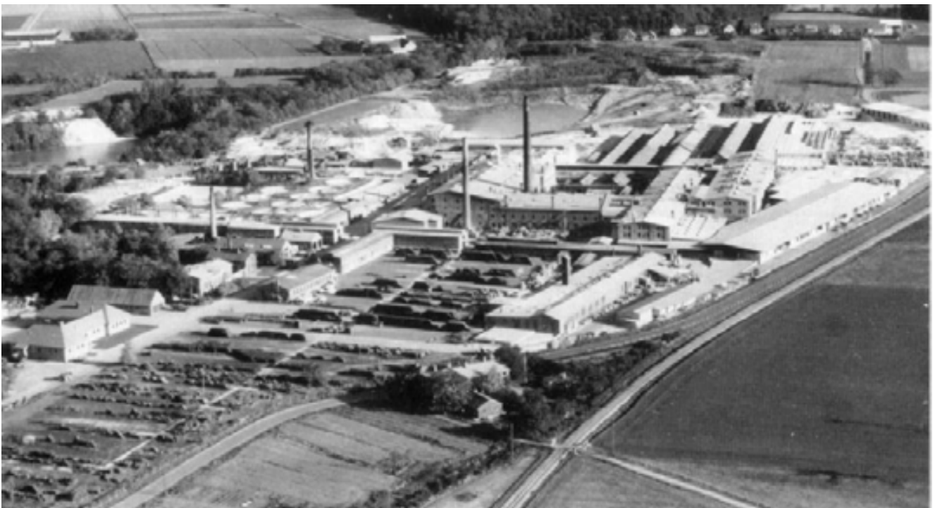
Rabækkeværket i 1955. Til venstre ses de store runde kaolinslemmekar, og midt i anlægget selve bearbejdningsanlægget med ovn. Dette anlæg gav på sit højeste i årtierne efter Anden Verdenskrig beskæftigelse til 600 til 900 mand.
