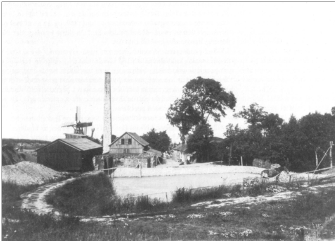
Allinge Teglverk 1907. I baggrunden en vindmølle, benyttet som drivkraft på værket.
