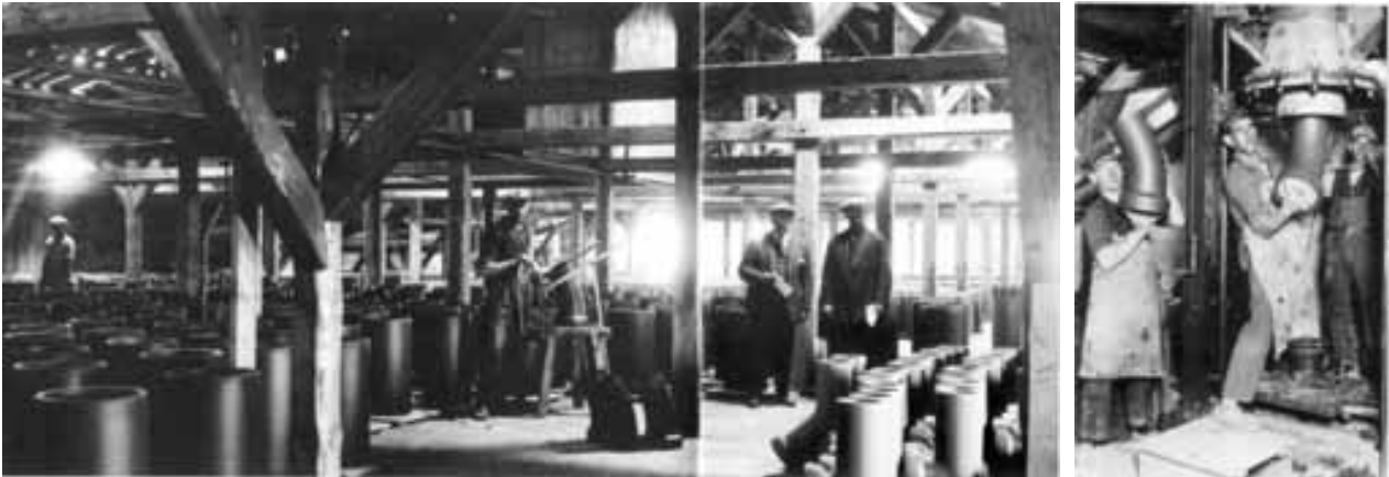
Fremstilling af glaserede rør til kloakering på Rabækkeværket. 1933.
