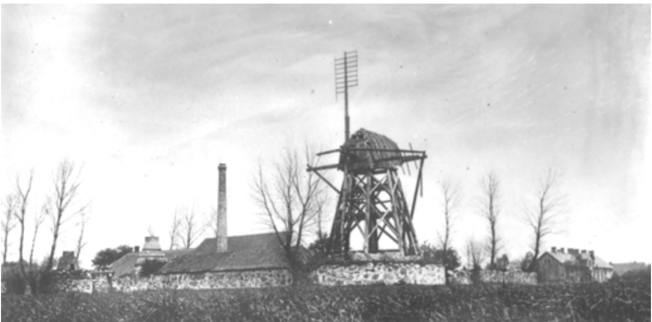
Cementværket "Phønix" syd for Rønne, omkr. 1920. Ovne, læskehal og mølle til maling af cementen. I baggrunden sygehuset
