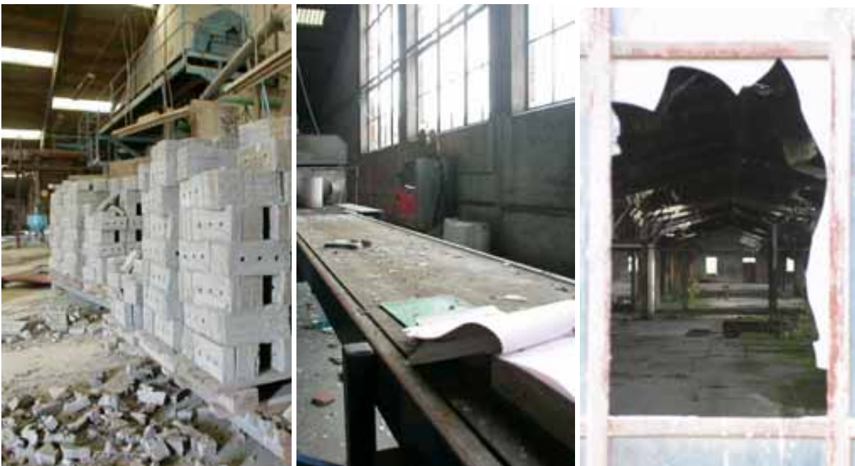
Hasle klinker efterår 2004. Et trist syn, hvor man fornemmer, at alt er forladt fra det ene øjeblik til det andet. Ubrændte sten, en åben ordrebog på transportbåndet, forfald og omfattende hærværk.
