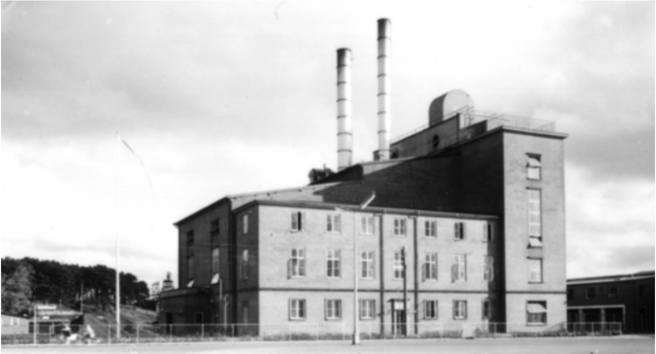
Det store nye Højspændingsværk, 1952, opført under Anden Verdenskrig, beregnet på at forsyne hele øen med vekselstrøm.
