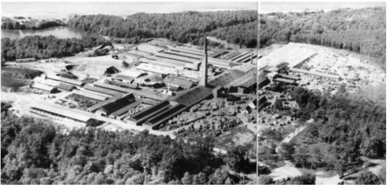
Hasle Klinker i 1956. Fjernest i billedet ligger havet, og tæt ved stranden den store lergrav. Centralt i området markerer den høje skorsten den store ovn.
