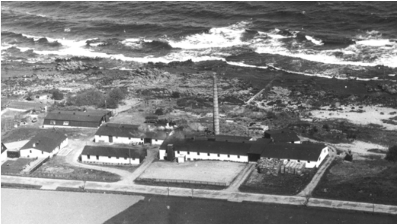
Bornholms Fiskemølsfabrik, Sandager 1947, syd for Melsted. Bygningerne blev senere hønseri, og fungerer nu som moderne glaspusteri "Baltic Sea Glass". Skorstenen og flere af de mindre bygninger er nedrevet.
