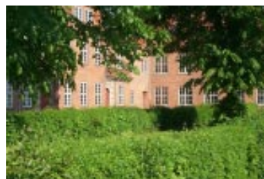
Hæk i gårdrum i belægningsbygning
